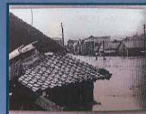
床上浸水と一部損壊の住宅
